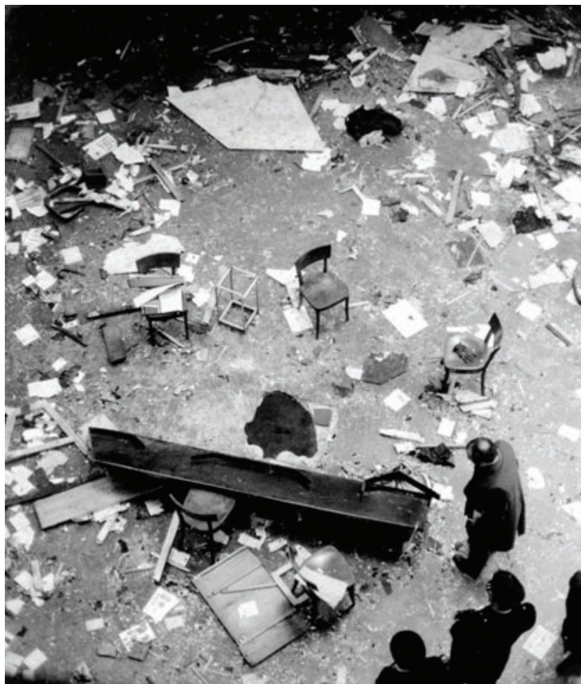
Milano, dicembre 1969: lo squarcio lasciato dalla bomba del 12 dicembre sul pavimento della Banca Nazionale dell'Agricoltura di Piazza Fontana.
