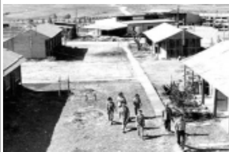
Anni Cinquanta, costruzione di un kibbutz nella valle di Arava
