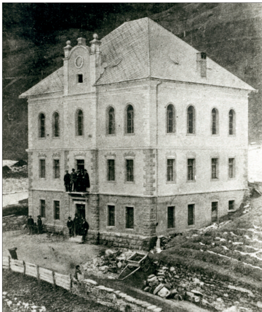
1913, i lavori alla Casa del Popolo di Prato Carnico prima dell'inaugurazione.
